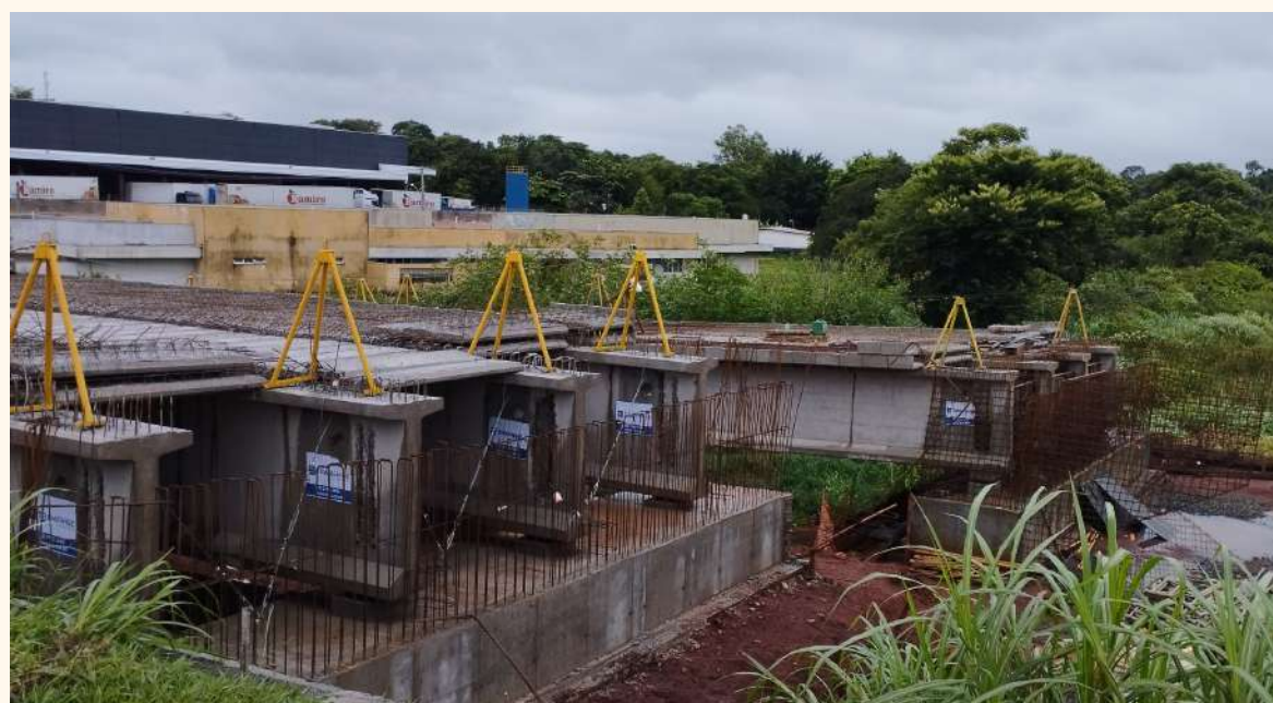
Foto - Estrutura da ponte sobre passagem de fauna - marginal sul Rod. Professor Zeferino Vaz km 117
