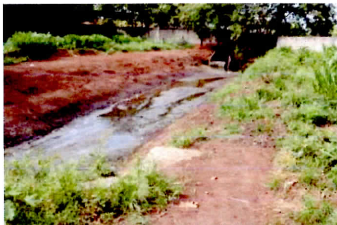
Foto 6 – Vala destinada ao escoamento de efluente sanitário tratado em lagoas de estabilização e de água de chuva que são produzidos na planta da CEASA e direcionados para o Bem Natural “D”
