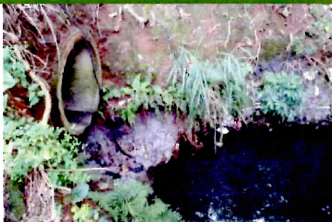
Foto 3 – Tubulação de água pluvial, com indícios de ligação cruzada com rede de esgoto no trecho entre os pontos 1 e 2.
